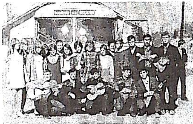
Очередной комсомольский десант отправляется на очистку Ириклинской ГРЭС.
